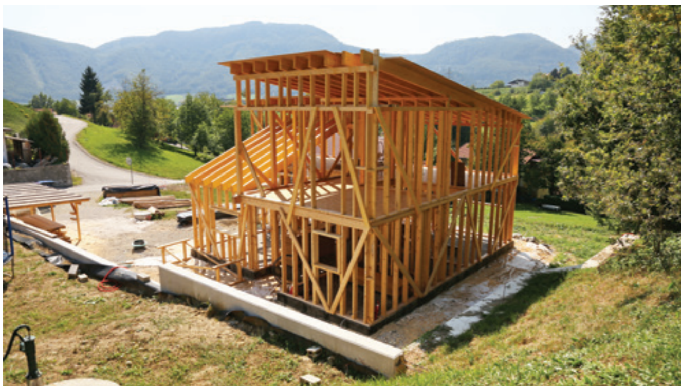
Leseni skelet pred vgradnjo konopljinoga betona.
