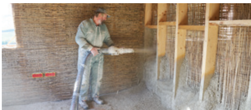
Brizganje konopljinoga betona na trajni opaž iz trstike, na katerem bo izveden glineni omet.
