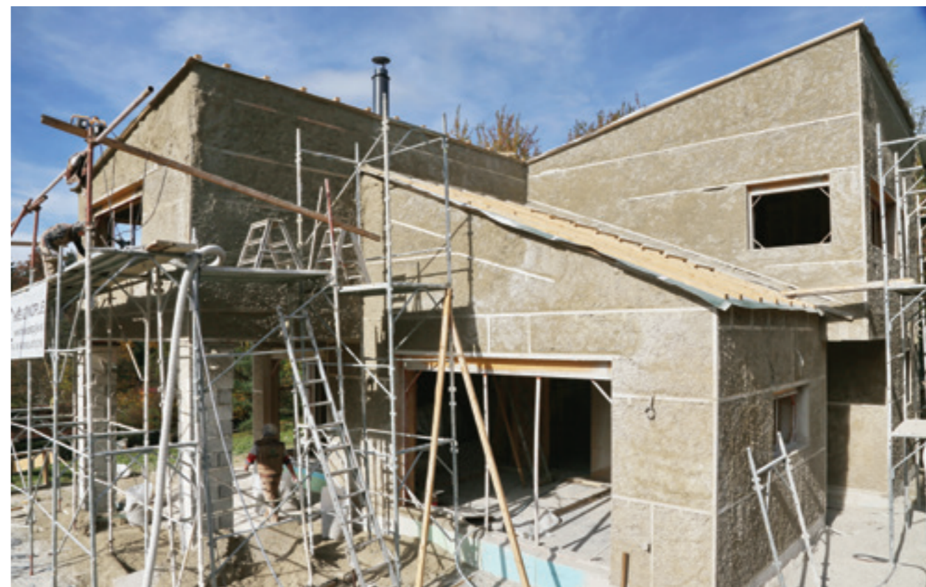
Objekt pred izvedbo zaključnih slojev.
